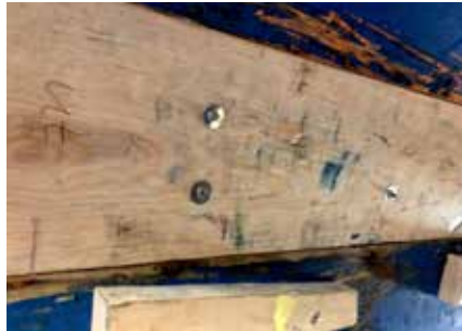
Bordet temporärt monterat med 4mm gängad stång.
