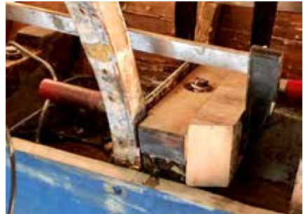
Bottenstock reparerad med ny överdel pålimmad och fastdragen.
