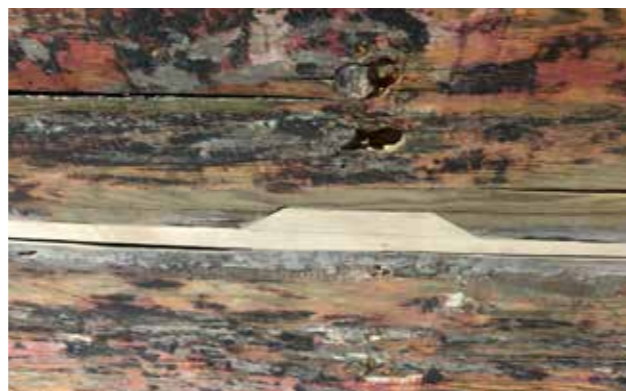
Bordläggning med ett spruns, till en nåtlimning med ett extra spruns.
